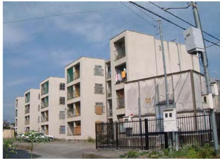
解体3号館 外観
