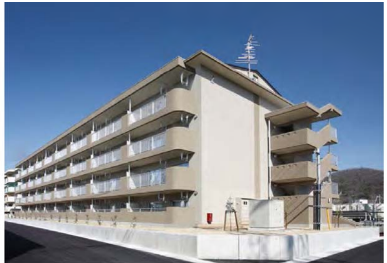
2号棟 南側外観
