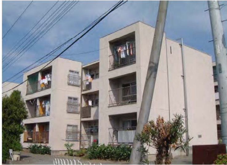
解体1号館 外観
