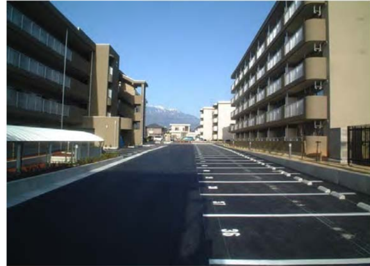
駐車場（透水性舗装）
