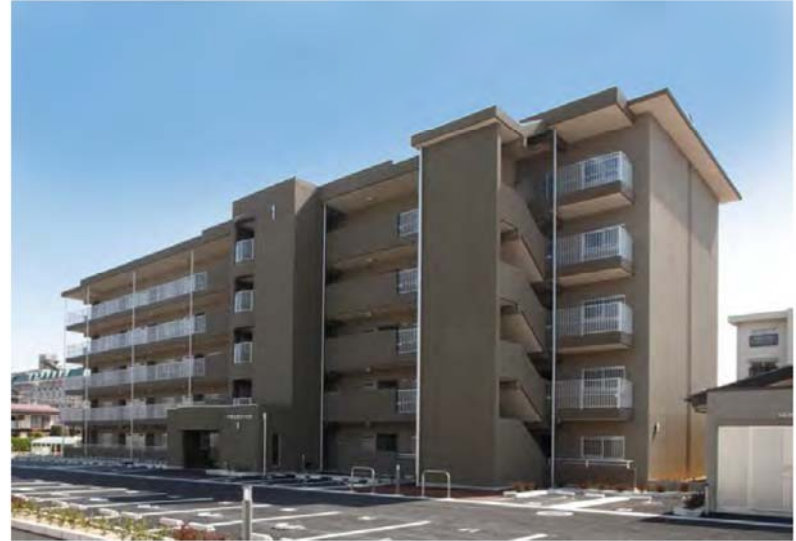
1号棟 北側外観
