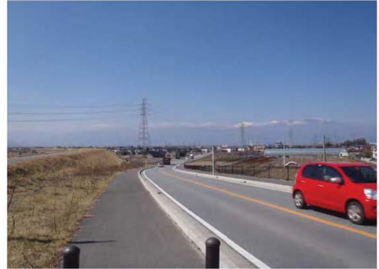
②バイパスの状況
