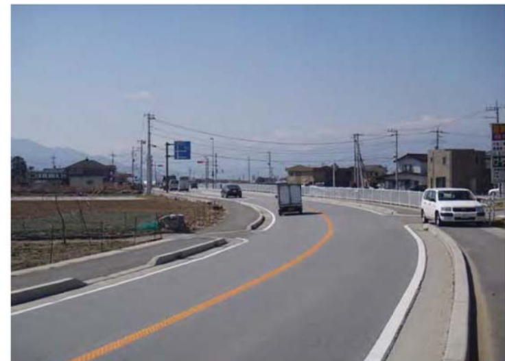
④バイパスの状況
