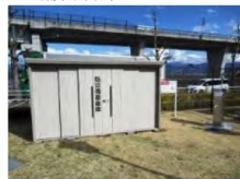
非常時に使用する資材等を保管
