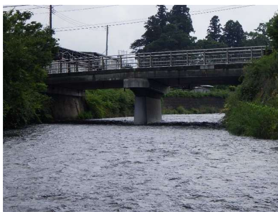
調査地点遠景・上流側（昭和橋）
