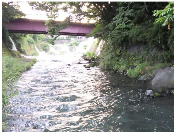
調査地点遠景・上流側（大橋）
