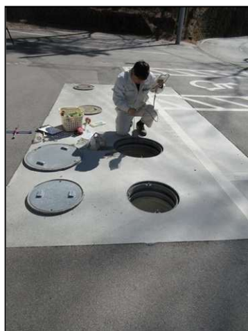
浄化槽法定検査
