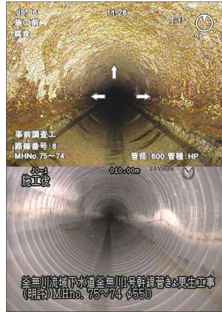
管きよ更生工事 上（更生前）下（更生後）
