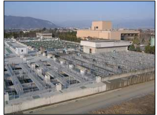
下水道施設 (峡東浄化センター)
