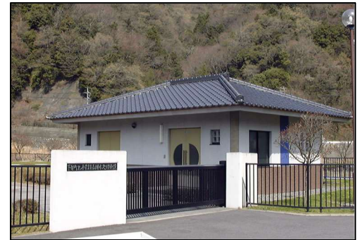
農業集落排水処理施設 (身延町上之平)
