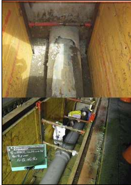
管きよ改築（更新）工事 上（更新前）下（更新後）
