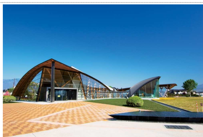
甲斐市玉幡公園総合屋内プール(平成18年度建築文化賞)
