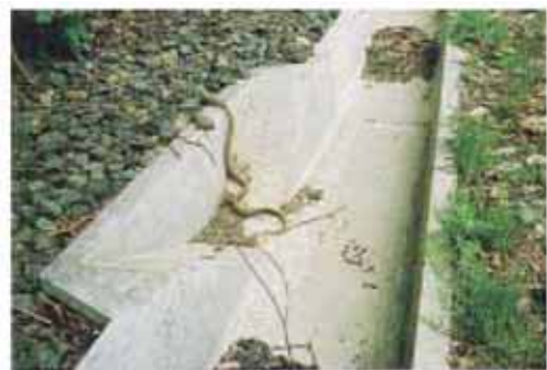
【スロープ付側溝を設置】
