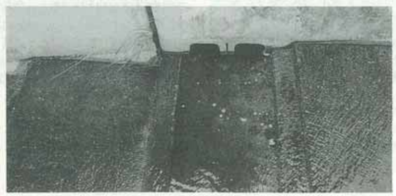
オオサンショウウオの隠れ場、各段階水路の下流部分や水路が50m以上になるところに設置している
