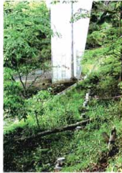
写真-事例 22-2 橋梁下の状況
