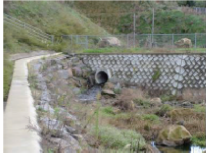
写真-事例6-1 横断路下流側(調整池側)
