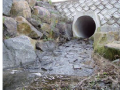
写真-事例6-2 横断路下流側(調整池側)
