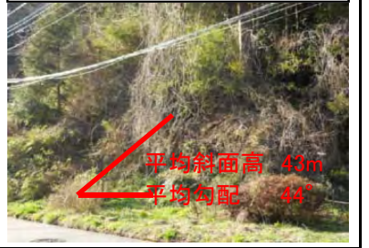
④ 斜面状況(近景)
