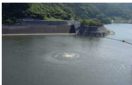
曝気装置による水循環の実施【大門ダム】
