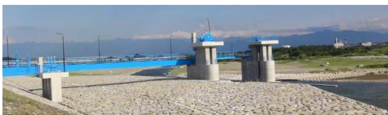
頭首工（農業用水利施設）
