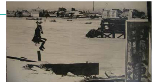
明治末期の水害の様子 [笛吹市甲連橋付近] 橋が流失したため、鉄線を架け滑車を用いて救援を行う
