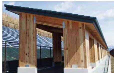
CLT工法を採用した屋外休憩施設
