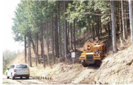
林内路網の基幹となる林道から枝分かれした森林作業道
