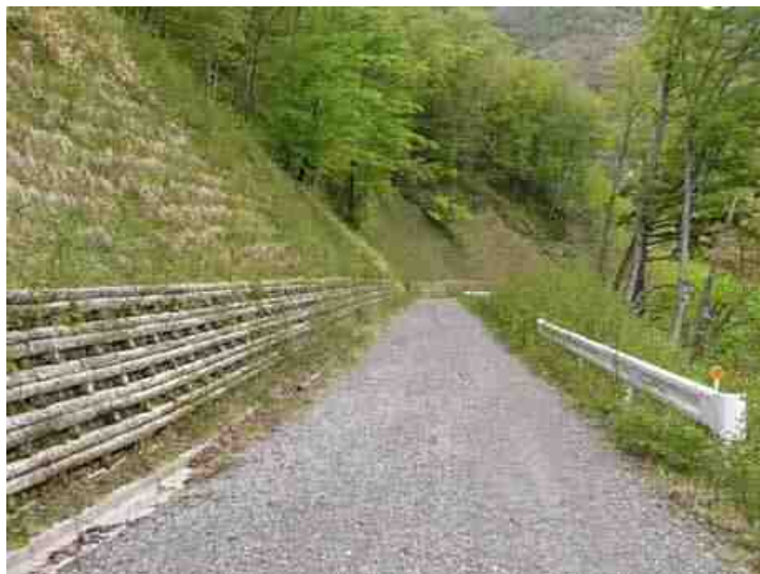
景観に配慮した林道整備状況
