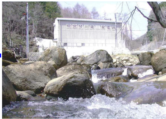
琴川第三発電所(山梨県企業局)
