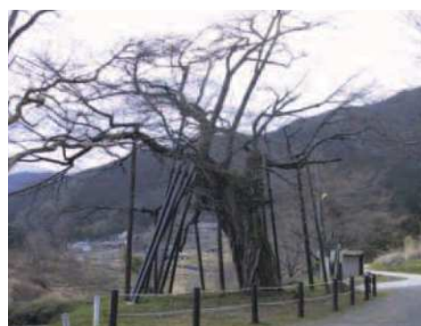
傾いた樹木を支柱により補強した事例
