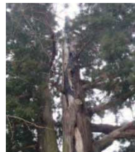
落雷による被害(火災が発生)
