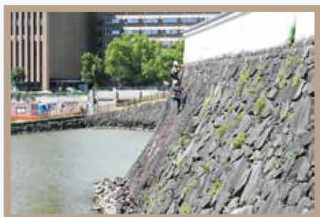
石垣の点検の様子
