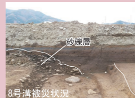
8号溝被災状況
