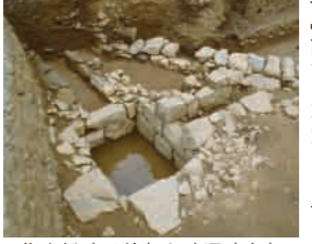
集水枡(手前)と暗渠(奥)。
