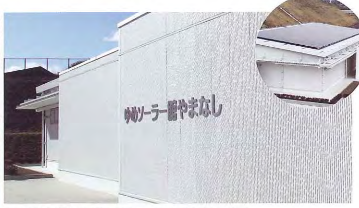
建物の屋根には20キロワットの太陽光パネルが設置されています。
