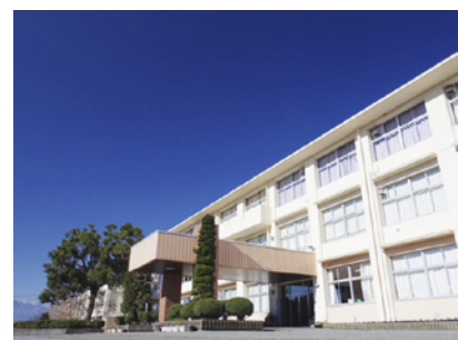
改修された校舎
