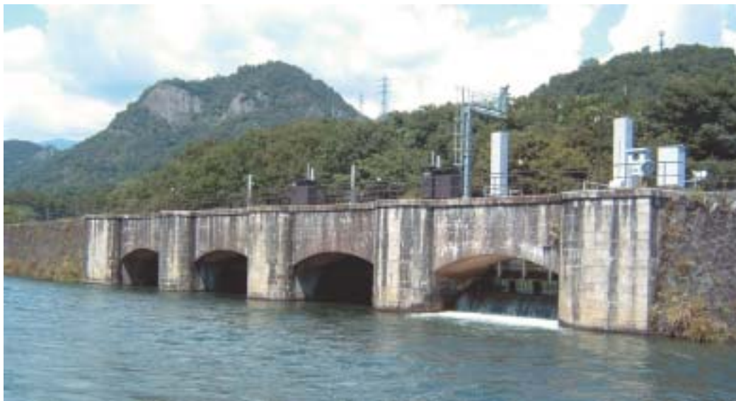
〈取水口制水門〉
