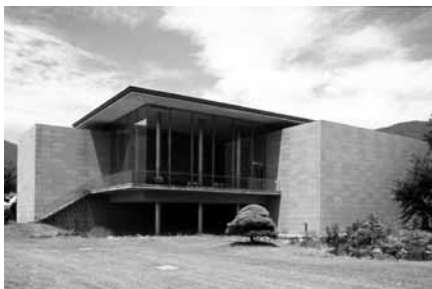
建物外観池方向から
