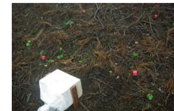
土砂受け箱設置状況
