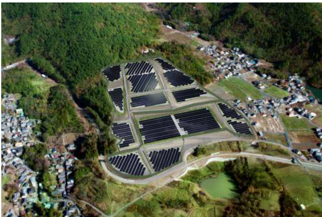
やまなしメガソーラー（甲斐） 5,085kW 平成 25 年 8 月運転開始予定
