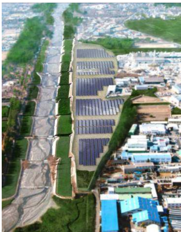
やまなしメガソーラー（韮崎） 5,256kW 平成 26 年 1 月運転開始予定
