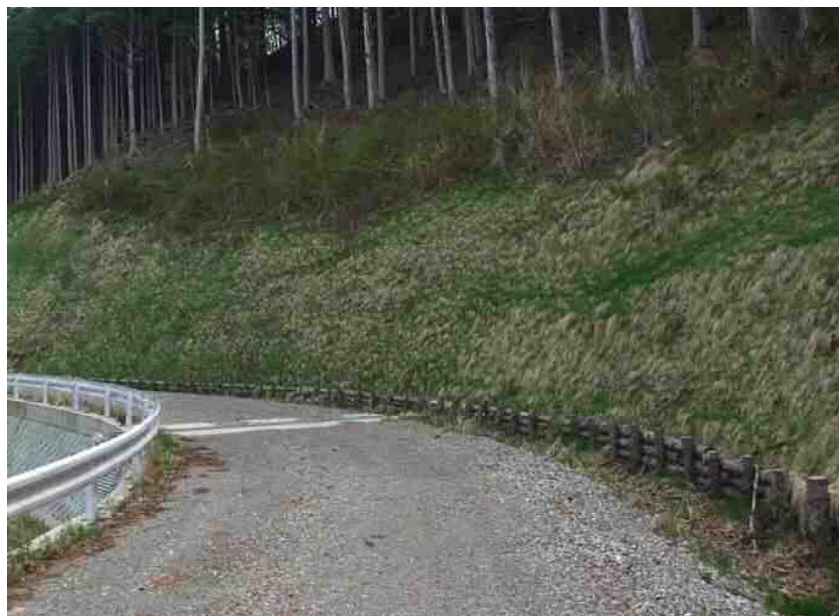
既設林道状況
