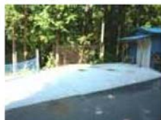
耐震性貯水槽
