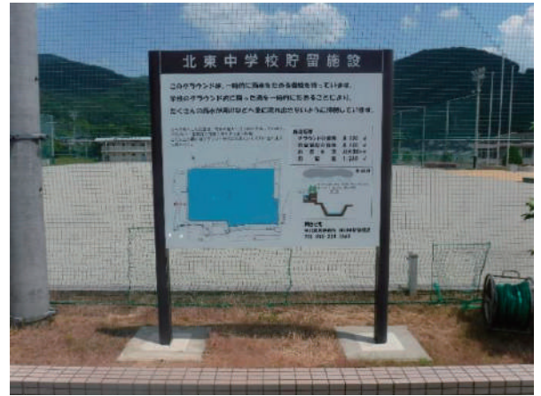
貯留施設（学校のグラウンドを利用）
