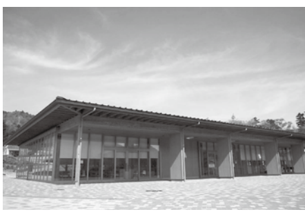
県産材を利用した富士クラフトパークエントランス棟
