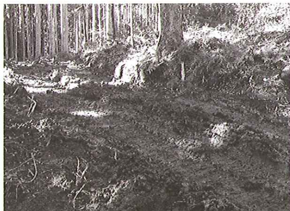
▲写真 高含水率状態の路面を重機が走行した後の様子
