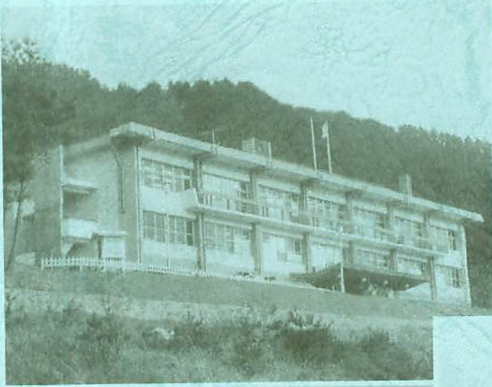
林業試験場(甲府市)
