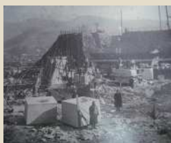
建設中の謝恩碑
