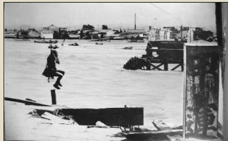
明治40年の大水害の状況（笛吹市甲運橋）
