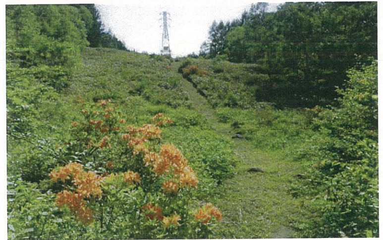
貸付箇所 4 (特別高圧線下)
