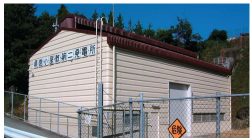
小屋敷第二発電所
