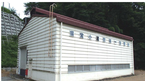
小屋敷第一発電所
