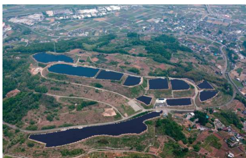
上空から見た米倉山太陽光発電所（全体）
