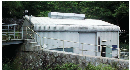
琴川第二発電所
