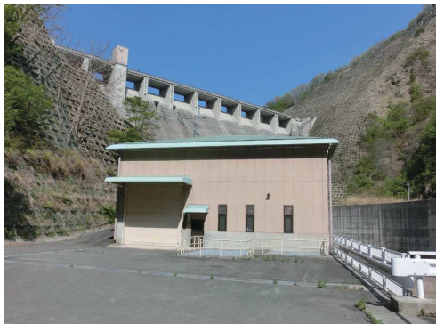
塩川発電所全景
