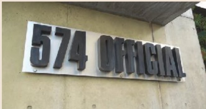
コンクリート打ちの外壁と、モノトーンの金属素材の文字のモダンな組み合わせ
