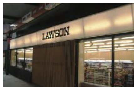
伝統的な街並みに合わせた外壁と淡い照明 ③④
