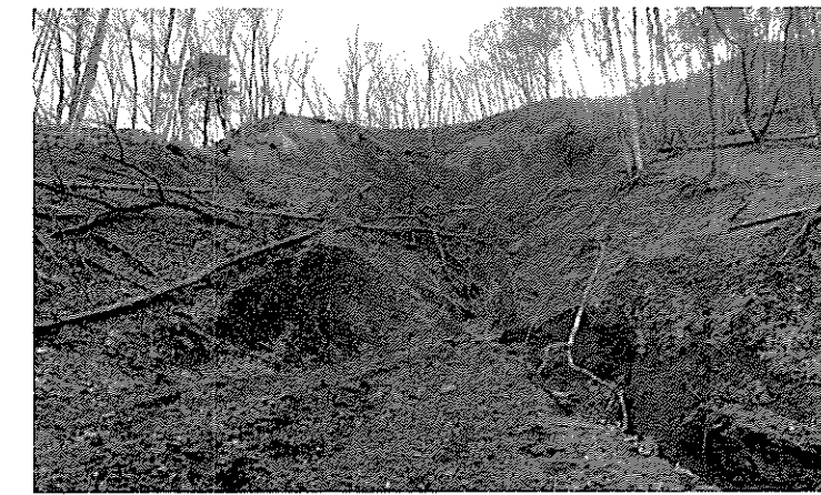
③ 谷止工上流荒廃状況
