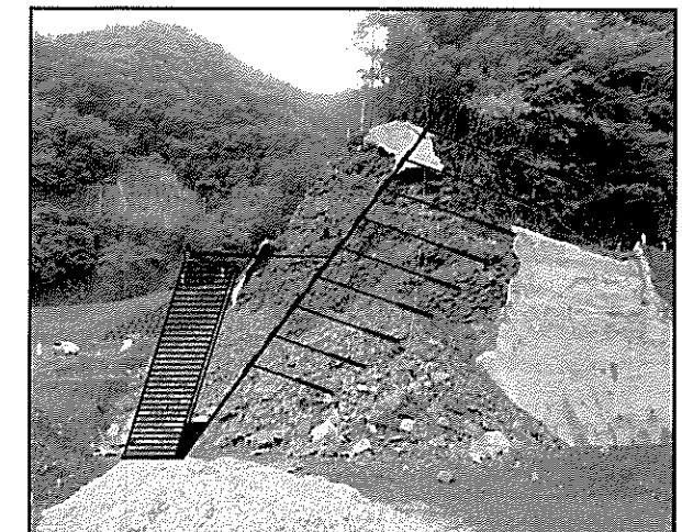
抑え盛土による応急復旧状況
