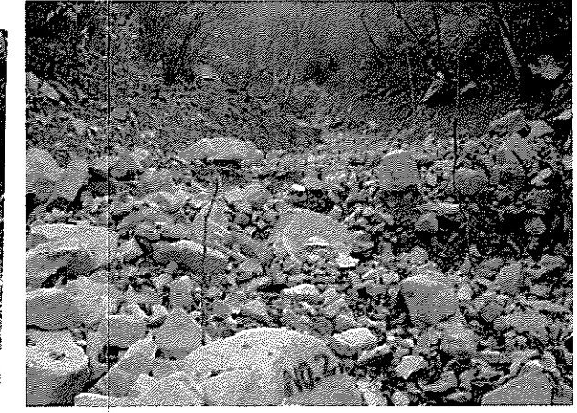
④ 谷止工上流荒廃状況
