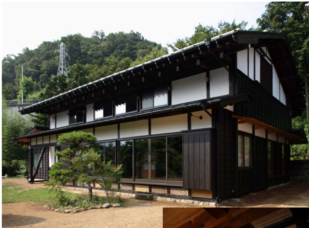
南側からの全景
