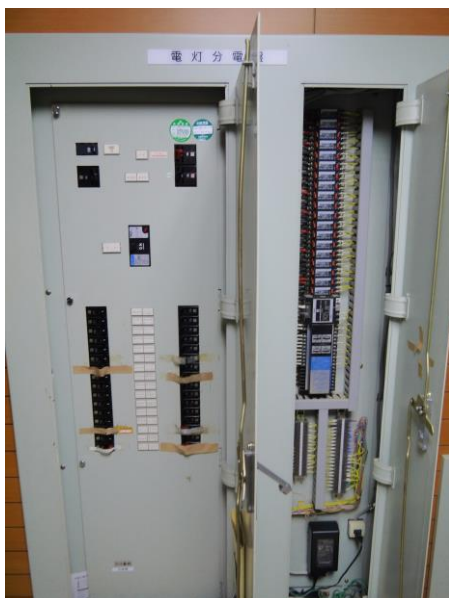
〔森林学習展示館の電灯分電盤及び低圧記録書記載の漏電遮断器〕
