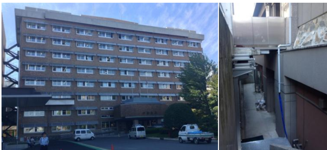
図Ⅱ－32 平成14年に免震改修を実施した本庁舎本館と地階の免震部
