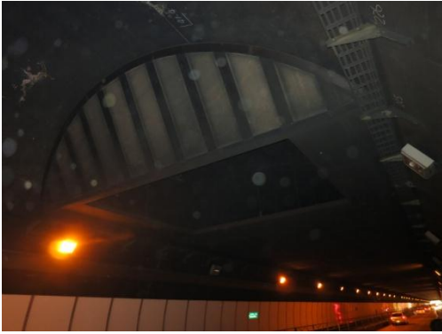
図 I - 25 吊り構造の天井板を有する愛宕トンネル(平成 25 年 12 月に天井板を撤去)
