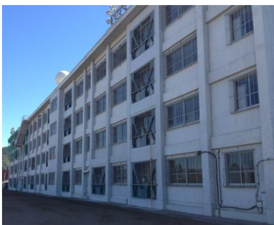
図Ⅱ－35 市川高等学校の耐震補強対策
