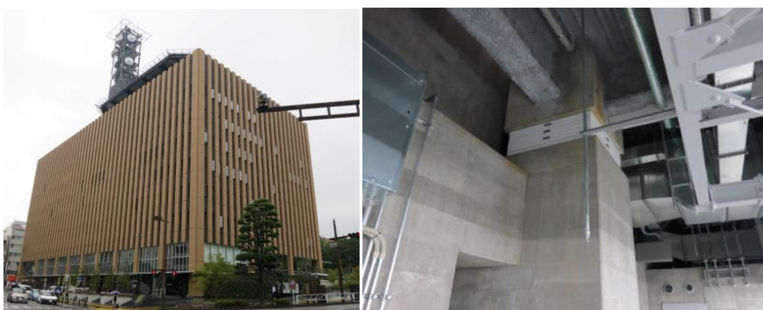
図Ⅱ－33 山梨県防災新館の全景と地下駐車場の柱に設置された免震装置
