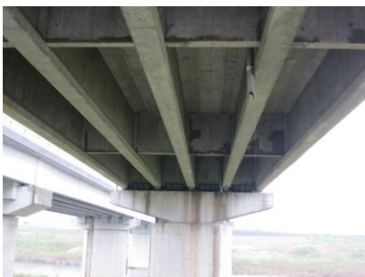
図Ⅱ－36 耐震補強を施す下曽根橋
