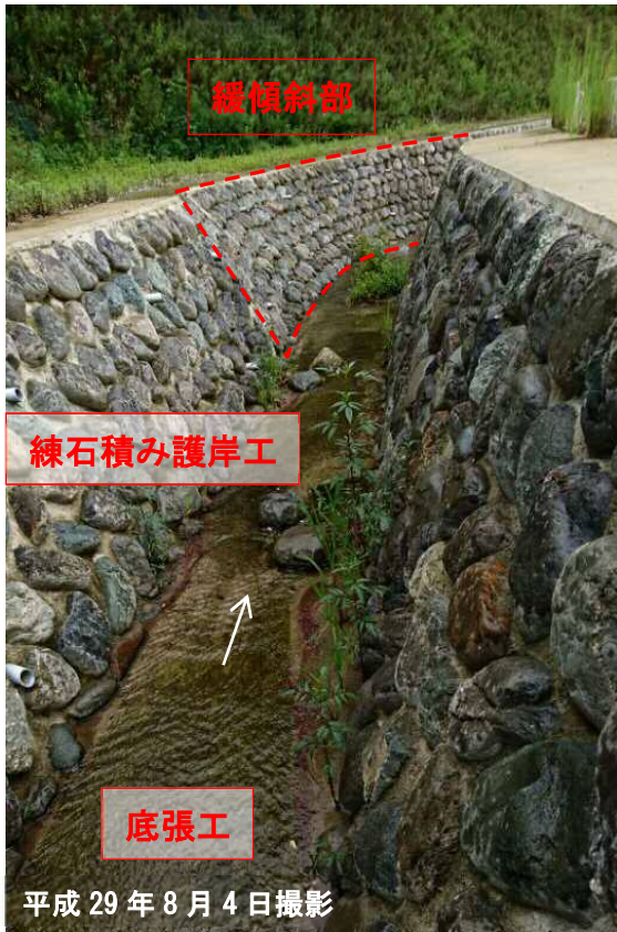
写真 1 練り石積み護岸工（緩傾斜部）
