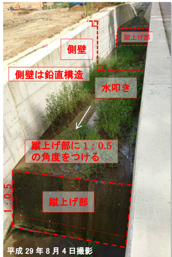
写真 4 落差工（急勾配区間）
