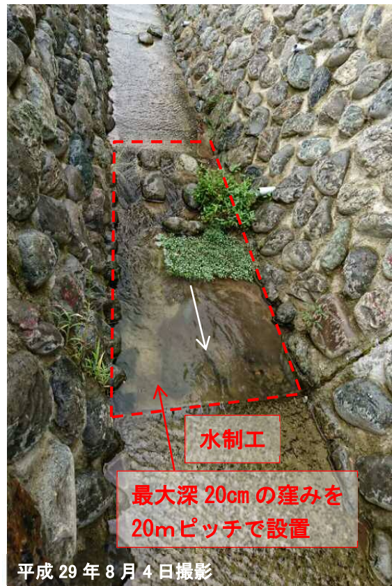
写真 2 練り石積み護岸工（水制工）
