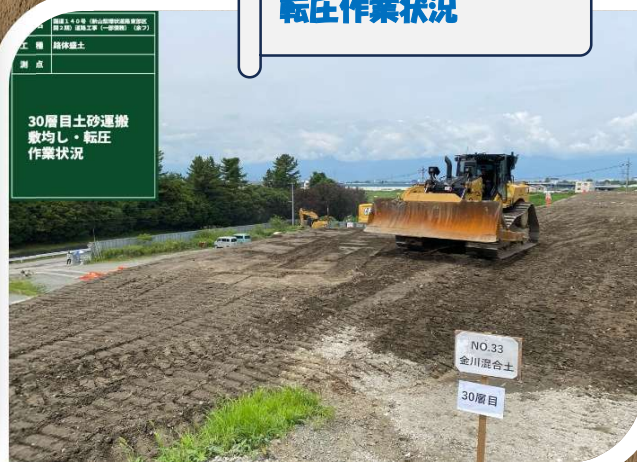
ICTブルドーザーによる 転圧作業状況
