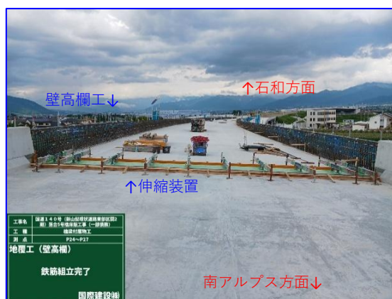
伸縮装置設置・壁高欄工鉄筋組立完了状況
