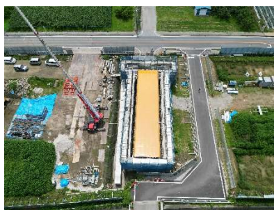
場所打函渠工 生コン打設
