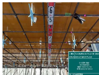
場所打函渠工 配筋検査
