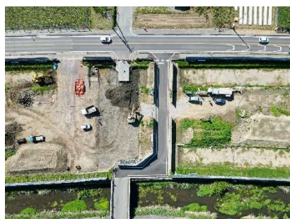
2号横断暗渠工 施工状況
