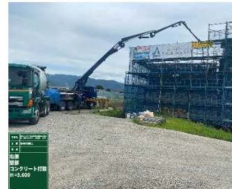
壁部コンクリート打設状況
