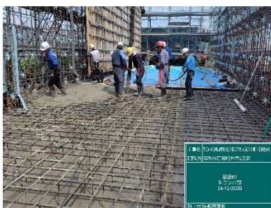
場所打函渠工 生コン打設
