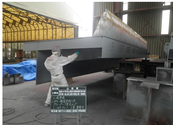
橋梁製作状況
