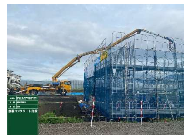
底版コンクリート打設状況
