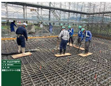
底版コンクリート打設状況
