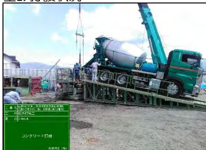
生コン打設状況
