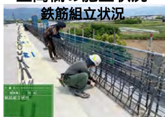
壁高欄の施工状況
