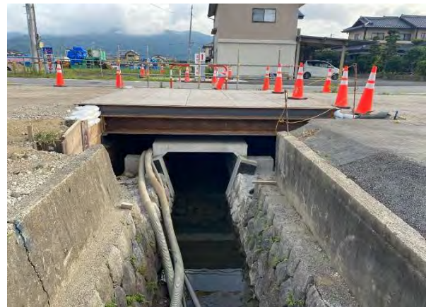
ボックスカルバート・覆工板
