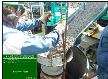
生コン打設状況
