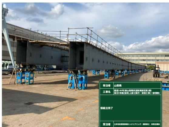
橋形式：3径間連続非合成鋼細幅箱桁橋
