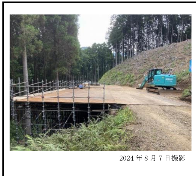
仮設ステージの設置状況（No. 35）
