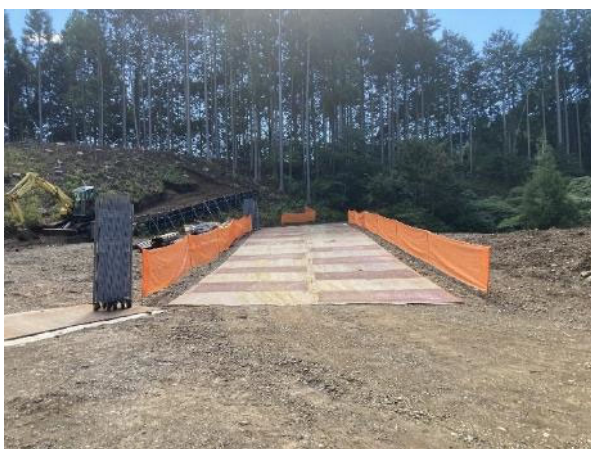
仮設道路 施工後 2024年9月21日撮影
