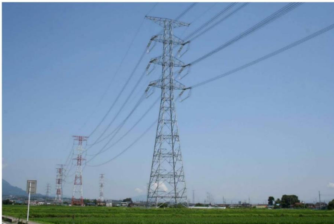
図 1. 4. 2-4 (6) 工事状況の例（架線工事）
