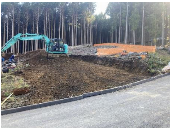
仮設工事 施工中 2024年11月13日撮影
