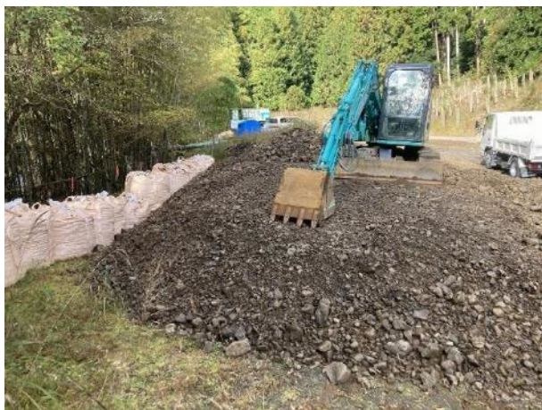
土嚢による土砂流出防止の状況
