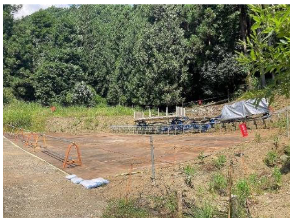
モノレール基地及びモノレール 施工後 2024年8月9日撮影
