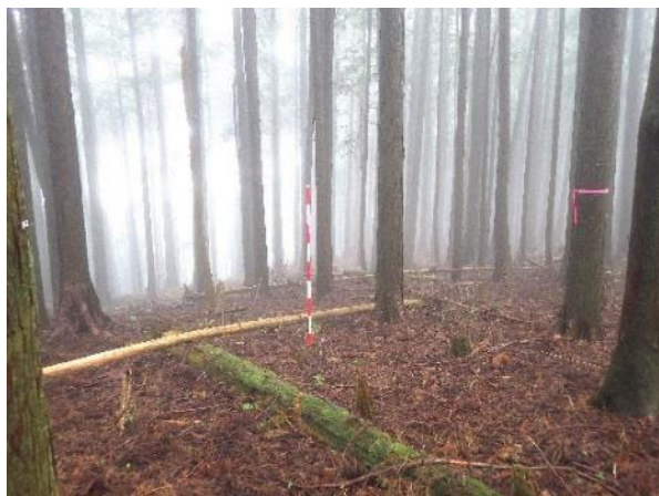
鉄塔 No. 31 工事用地の環境 2023 年 8 月 24 日撮影
