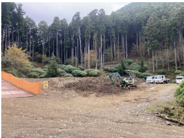
残土処理場 施工中 2024 年 11 月 12 日撮影
