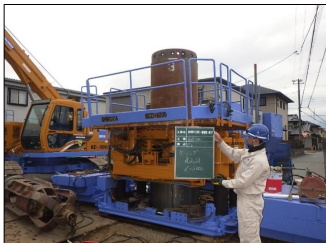
橋梁部における軟弱地盤対策の追加 (基礎工：マイクロ全回転工法)
