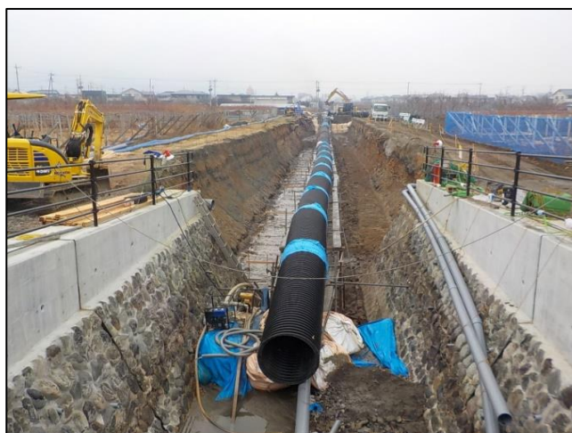
狭隘な施工ヤードにおける仮排水路
