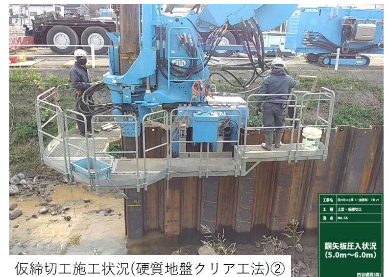
仮締切工施工状況(硬質地盤クリア工法)①
