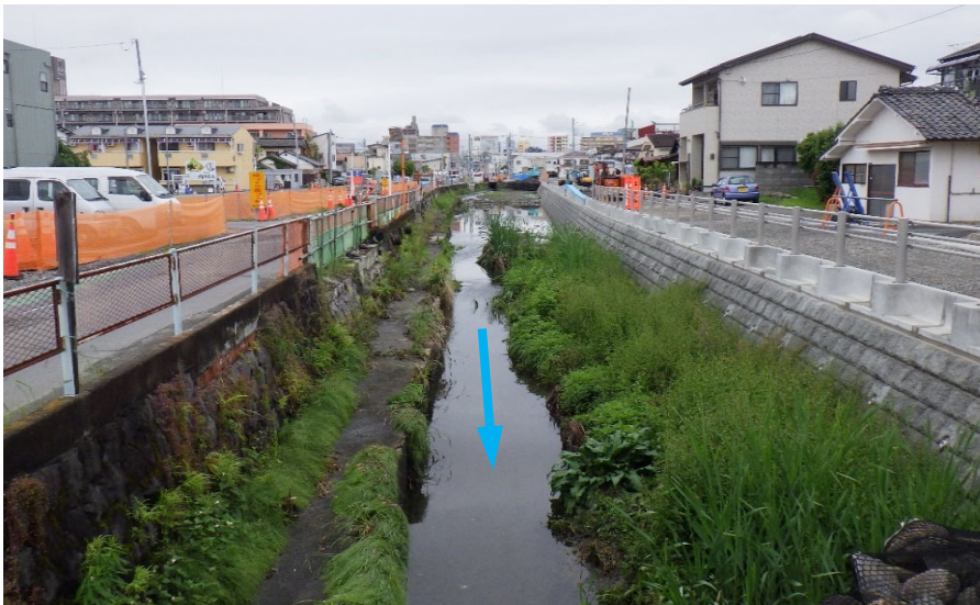
③ 省路橋上流付近
