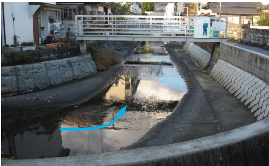
⑤ 開運橋上流屈曲部
